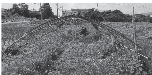
写真1.ハウスの骨組みだけの状態 (平成30年5月撮影)
