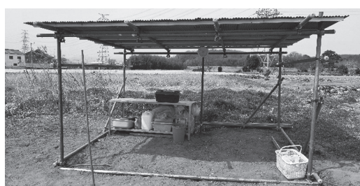
写真3.完成直後の小屋 (平成31年3月撮影)
